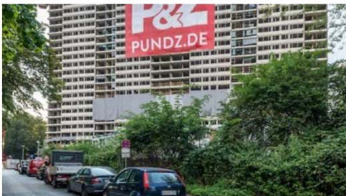
Fig. 2: White Giant and Ottostraße, Photo: Toma Babovic Sprenggesellschaft mbH
