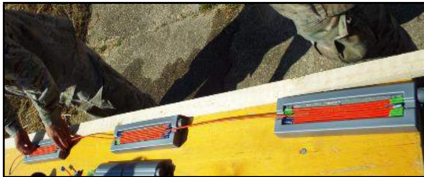
6. kép: Robbanó gyújtózsín behelyezése (a szerző felvétele)
