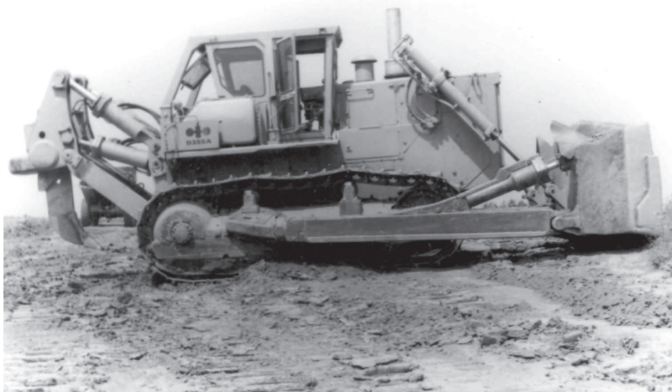
19. Tépőszerezékes nehéz dózer
