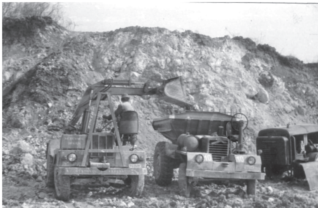
15. Hazai gyártású, 0,5 \text{ m}^3 kanalas rakodógép 3,5 \text{ m}^3 puttonyos VÖCSI dömperrel
