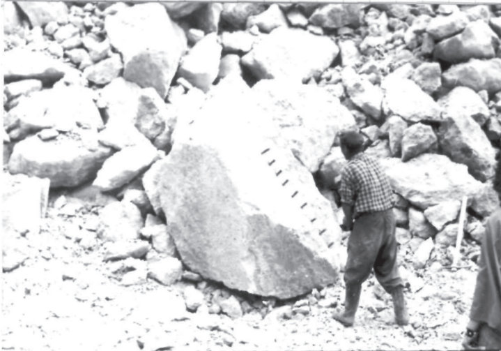
1. Kőtömb hasítás ékekkel, nehéz kalapáccsal
