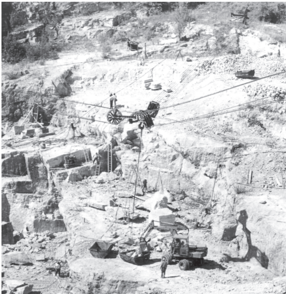
22. Házi tervezésű es építésű 3-dimenziós kábeldaru a Süttői, tömbkőbányában. Kitűnő szerkezet volt tömbök és meddővel rakott csille- teknők járműre emelésére.
